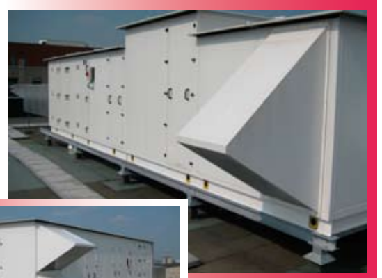
HC TN luchtbehandelingkast met verhoogde warmtewielsectie
