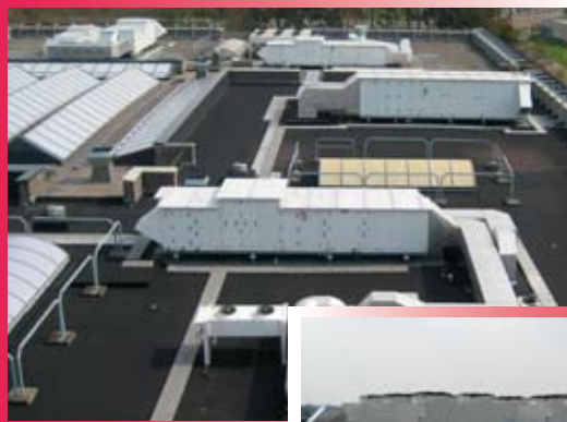
Overzicht dak laagbouw
