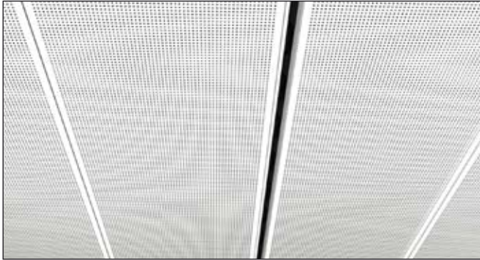
Voorbeeld: straallijnrooster tussen plafondplaten (breedte 20 mm)
